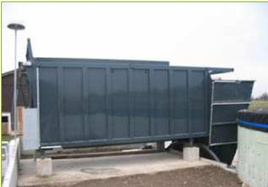
***Cassone dosatore per automatizzare le operazioni di alimentazione del digestore***
