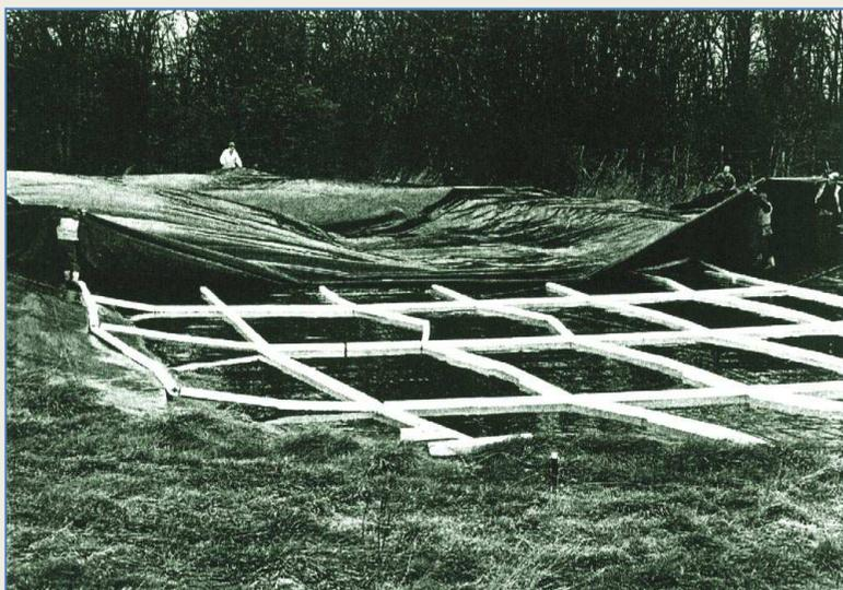
Disposizione di un telo in **polietilene nero** (resistente a UV) su un lagone in terra della superficie di 525 m<sup>2</sup>.
