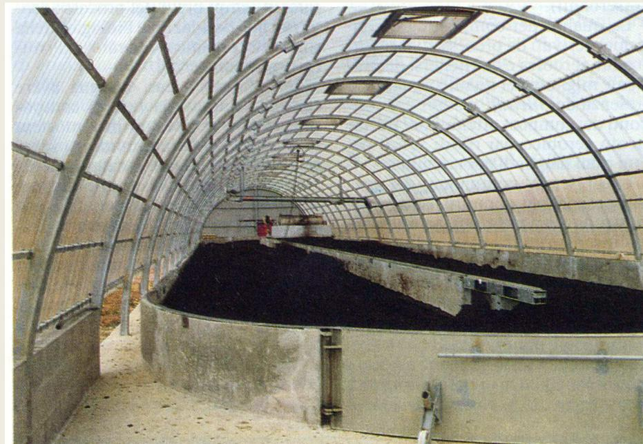
**Impianto di compostaggio di seconda generazione (Kischi), realizzato in Francia, per il trattamento di deiezioni suine (Foto in alto). Il caricamento della tramoggia avviene mediante il trasportatore trasversale visibile in alto. (Foto sopra). Vasca a «carosello». Da notare il ricambio d'aria nella struttura di copertura a serra: entrata dell'aria, da entrambi i lati, in basso; fuoriuscita dalle aperture sul tetto.**
