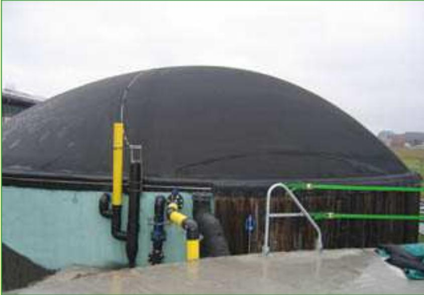
***Particolare della valvola di sovrappressione del gas***
