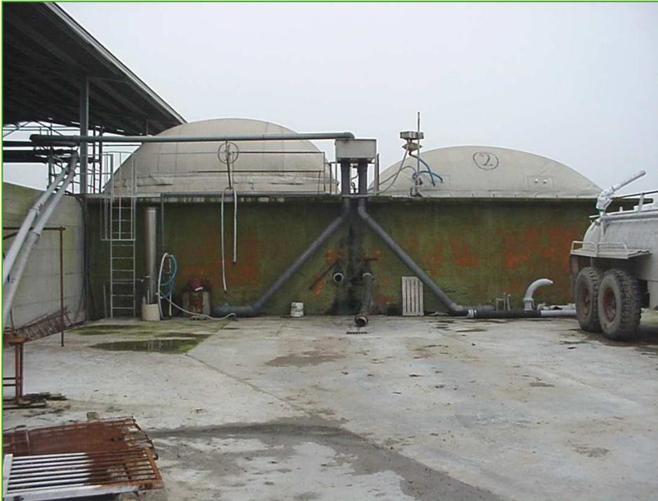
**Impianto semplificato di biogas: vasche riscaldate mediante serpentina; biogas recuperato mediante le coperture a cupola.**
