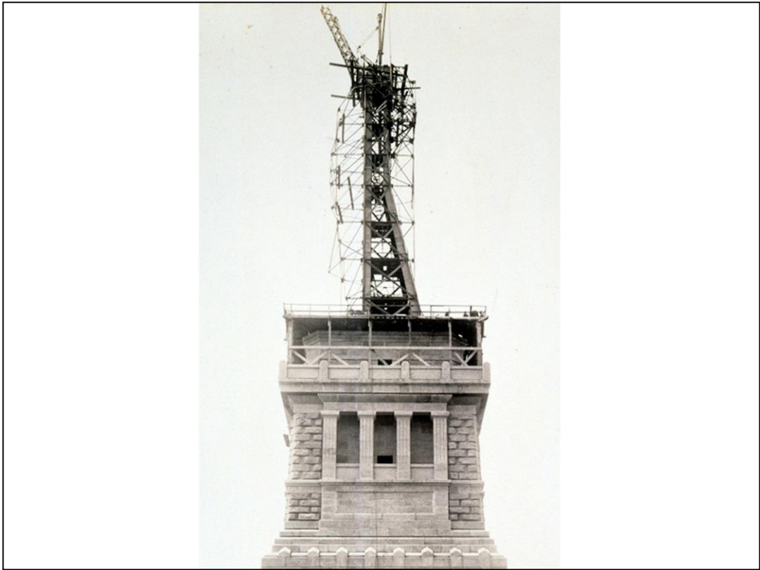
La statua della Libertà in costruzione, New York, 1880-1886
