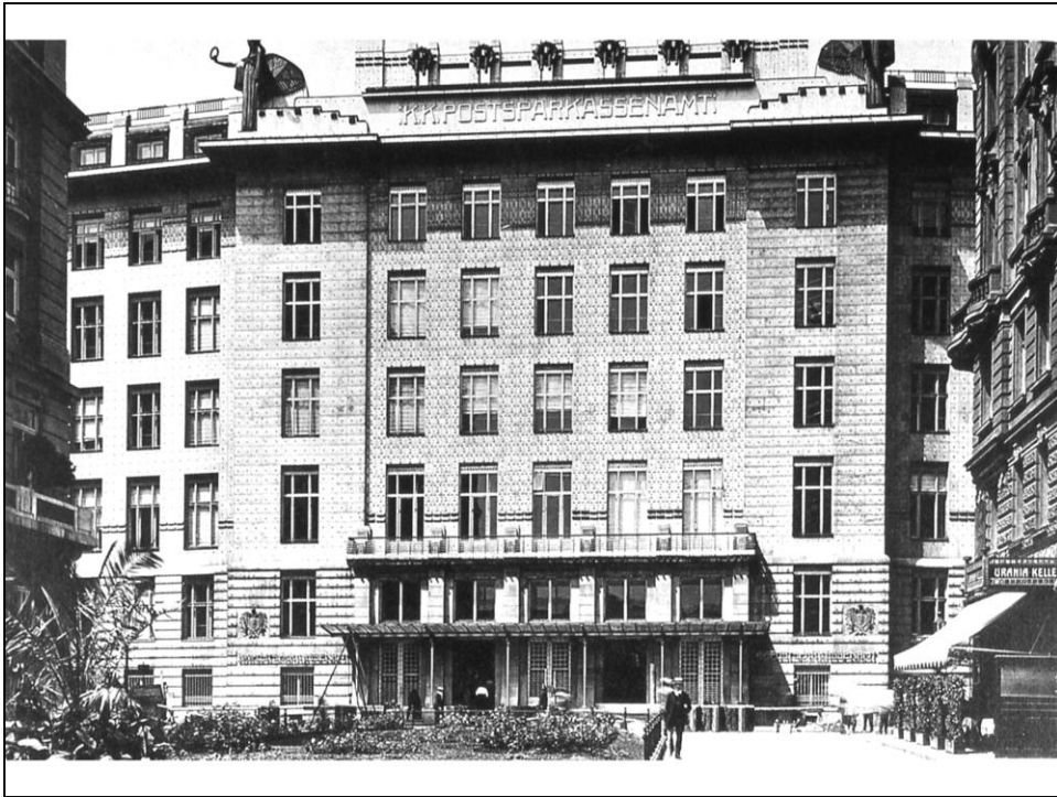
O. Wagner, Postsparkasse, Vienna (1904-12): facciata principale
