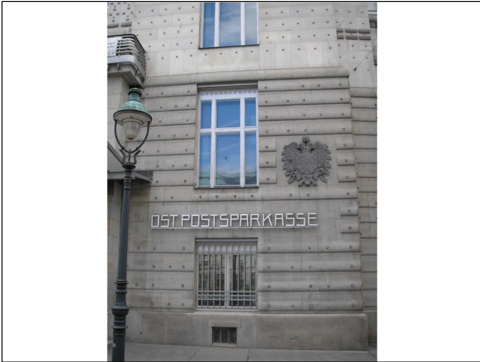
O. Wagner, Postsparkasse, Vienna (1904-12): dettaglio del basamento
