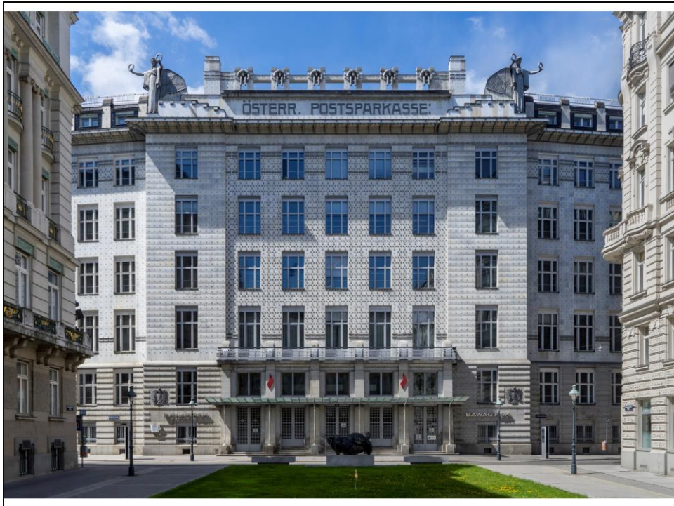
O. Wagner, Postsparkasse, Vienna (1904-12): facciata principale
