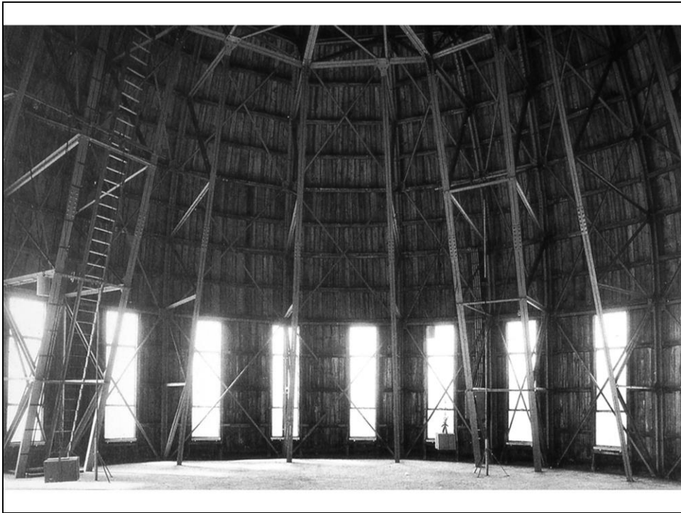
O. Wagner, Chiesa di St. Leopold allo Steinhof, Vienna (1902-06): la struttura metallica della cupola
