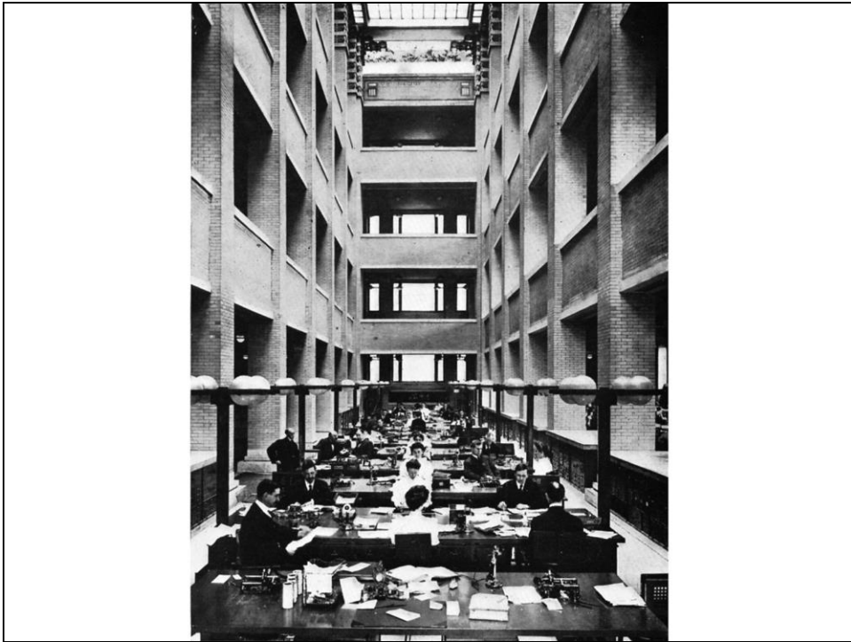
F.L. Wright, Larkin Building, Buffalo, N.Y. (1904-06): lo spazio interno a tutta altezza
