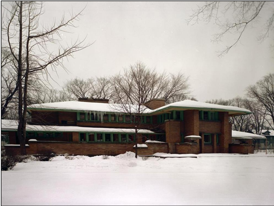
F.L. Wright, Darwin Martin House, Buffalo, N.Y. (1903-04): la facciata verso la strada
