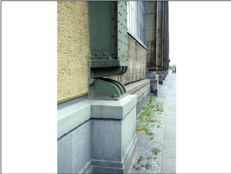
P. Behrens, Turbinenfabrik AEG, Berlino (1908-09): dettaglio di uno dei portali a tre cerniere
