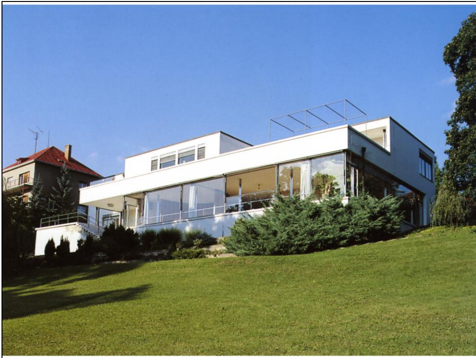
L. Mies van der Rohe, Casa Tugendhat, Brno (1928-30): la fronte meridionale
