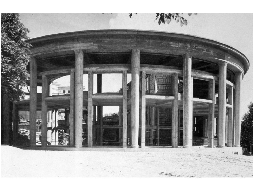
A. Perret, Musée des Travaux Publics, Parigi (1936-46): la testata in costruzione
