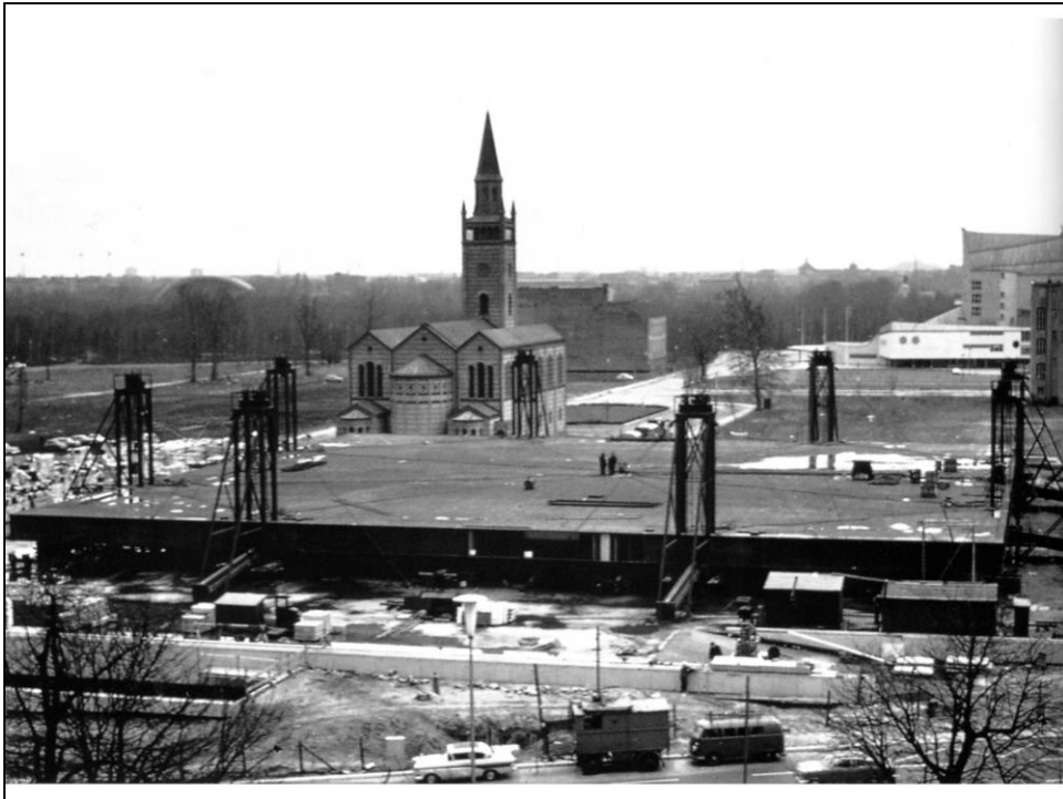
L. Mies van der Rohe, L'innalzamento della copertura della Neue Nationalgalerie, Berlino, 1967
