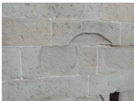
Figura 7: Parete muraria esposta all'aperto: esempio di erosione
