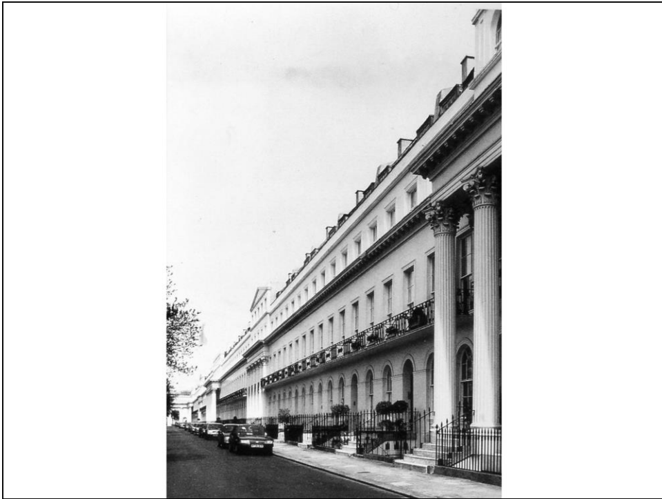
J. Nash, Chester Terrace, Londra: lato verso la strada
