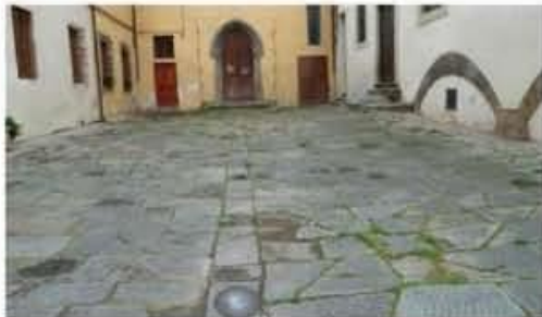
Cattivo stato della pavimentazione
