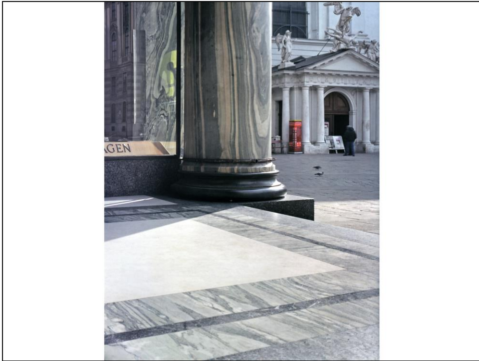
A. Loos, Edificio Goldman & Salatsch sulla Michaelerplatz, Vienna (1909-11): dettaglio dell'ingresso alla sartoria
