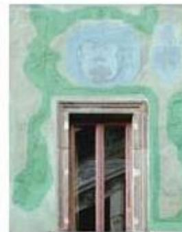
Pulitura a tampone con soluzione alcalina e polpa di legno
