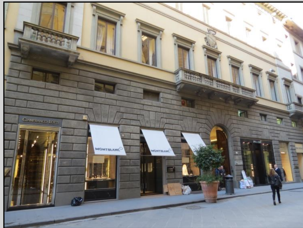
PALAZZO ALAMANNI (760) Via de' Tornabuoni 9
