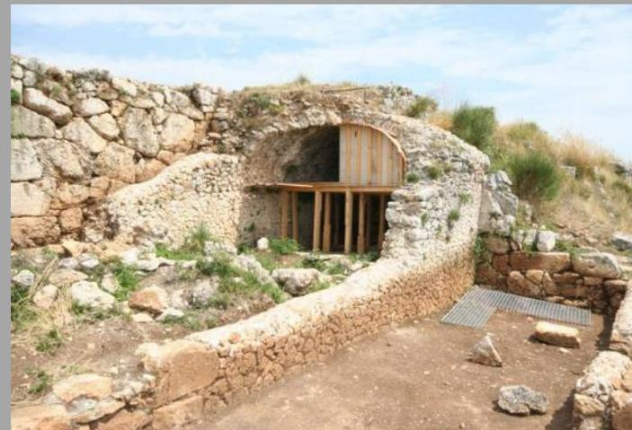
Rovine di Norba, *Castellum aquae* realizzato con strutture legate con malte in grado di fare presa in acqua per la presenza di pozzolana e calcarei silicei naturali macinati (calce bianca).
