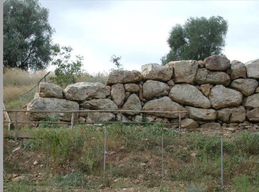
Opera poligonale con blocchi litici disposti in modo scalare
