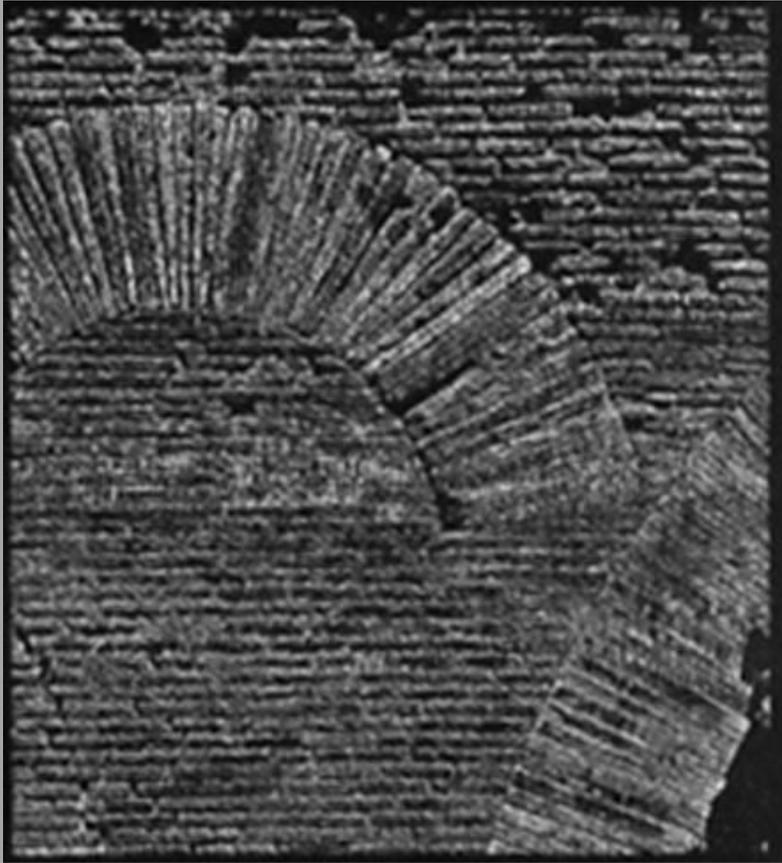
*Structura testacea (opus latericium)* di rivestimento con riempimento a sacco in conglomerato («empletto»)
