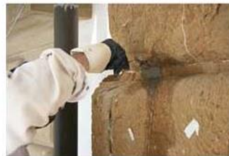
Preconsolidamento con applicazioni localizzate
