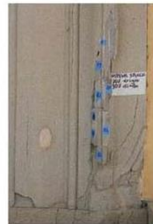
Consolidamento selettivo con stucco
