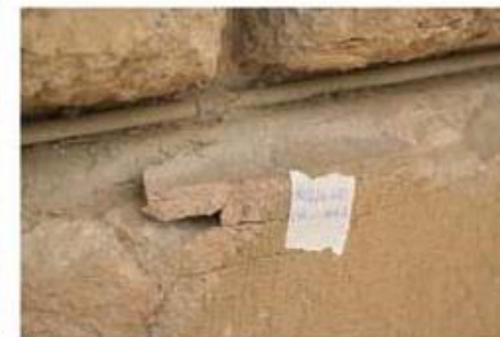
Consolidamento con resina epossidica
