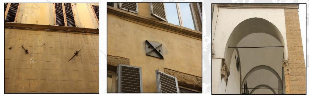
Alcuni interventi di adeguamento sismico sulle murature riaccontrati nell'area urbana
