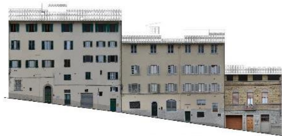
INTERVENTO DI CONSERVAZIONE - CASA DI MARGUCCI (100)
