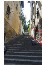
Avvicino di un cantiere lungo la rampa.
