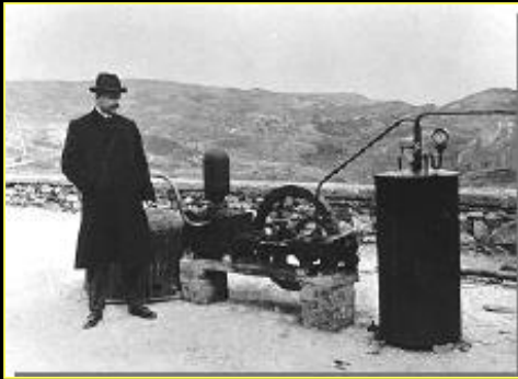
Principe Piero Ginori Conti con la prima macchina che produsse Energia Elettrica da vapore geotermico
