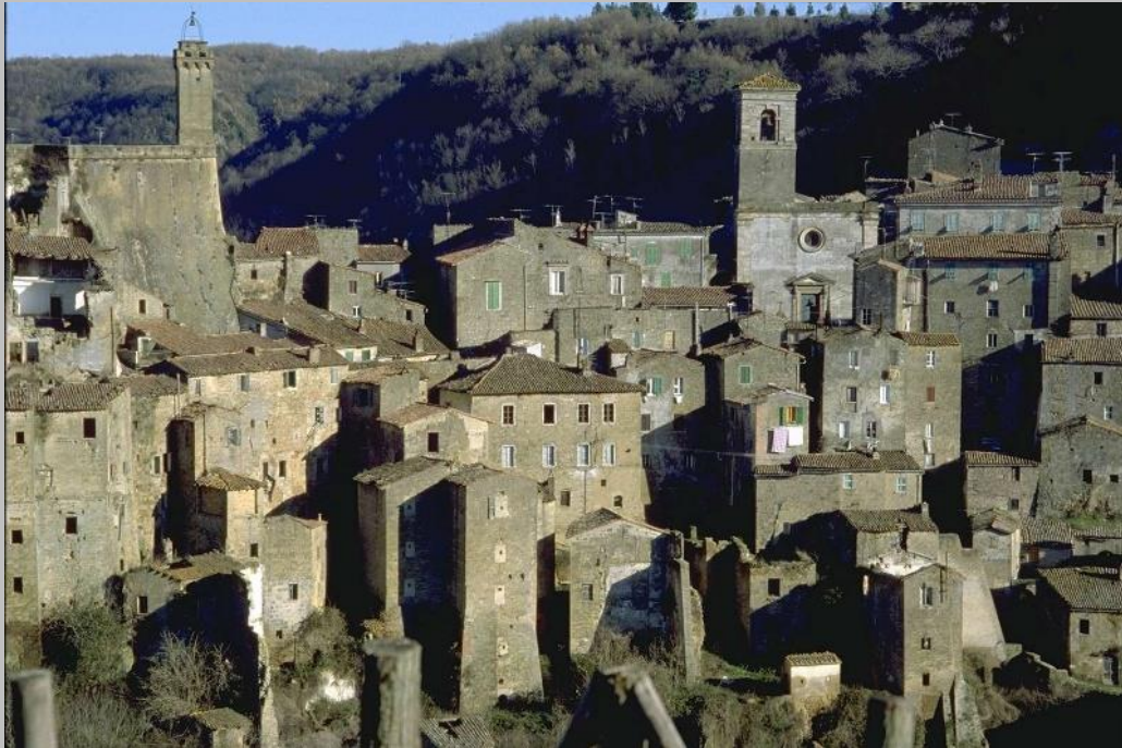
Sorano, il borghetto interessato dal movimento franoso della rupe
