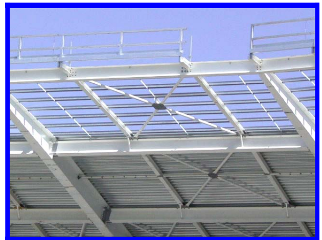
Copertura dello Stadio Comunale di Torino realizzata con nostri arcarecci rinforzati
