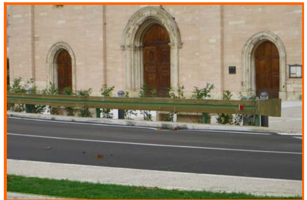
RIVESTIMENTO IN LEGNO DI BARRIERE METALLICHE presso Cascata delle Marmore (TR) in alto e presso Santuario di Rivotorto (PG) in basso
