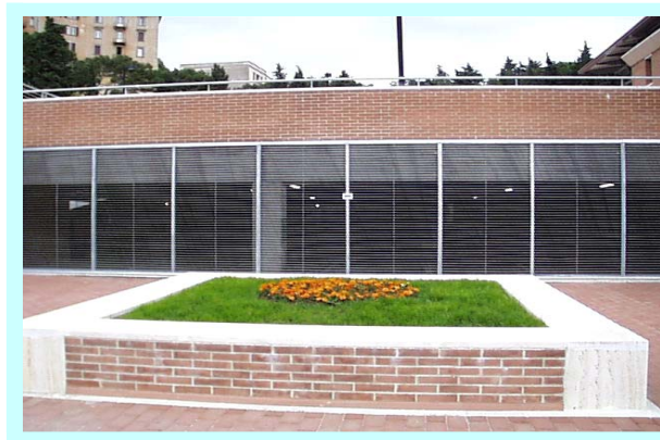
Parete areata realizzata con profilo SE024 per parcheggio Europark di Perugia
