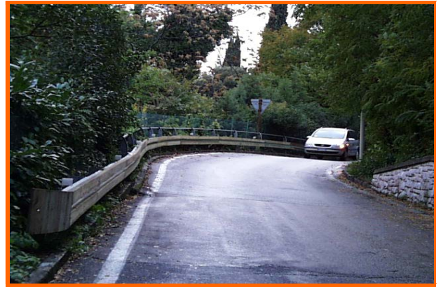
RIVESTIMENTO IN LEGNO DI BARRIERE METALLICHE presso SS147 di Assisi (PG)
