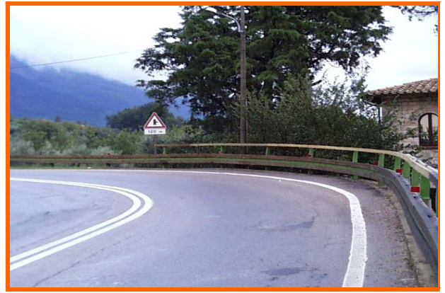
RIVESTIMENTO IN LEGNO DI BARRIERE METALLICHE presso SS147 di Assisi (PG)
