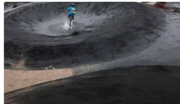
Belgepladsen: grandi conche nell'asfalto progettate per ritardare il deflusso della pioggia sono l'ideale per giocare con gli schizzi d'acqua / Belgepladsen: the big asphalt bowls designed to delay the rainwater are ideal for making big splashes © Carsten Ingemann
