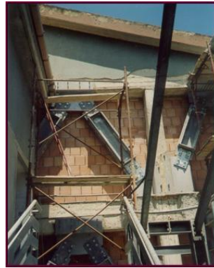
Adeguamento sismico della scuola "D. Viola" di Potenza
