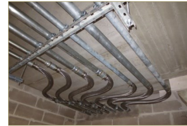
Immagini delle tubazioni del gas all'interfaccia fra impalcato mobile e sottostruttura
