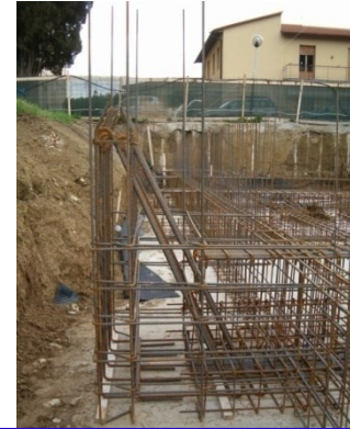
Vista delle armature dei contrafforti di reazione dei dispositivi silicnici
