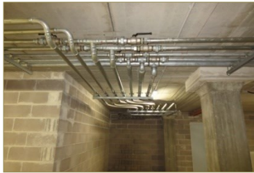
Immagini delle tubazioni del gas all'interfaccia fra impalcato mobile e sottostruttura
