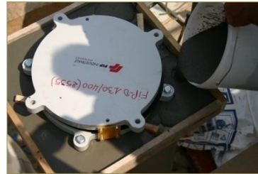
Posa in opera degli isolatori sul baggiolo
