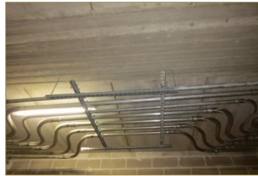
Immagini delle tubazioni del gas all'interfaccia fra impalcato mobile e sottostruttura
