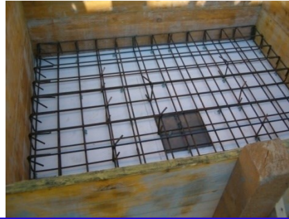
Vista dell'isolatore in acciaio-PTFE posizionato al disotto del vano ascensore, prima del getto della soletta intradossale dello stesso
