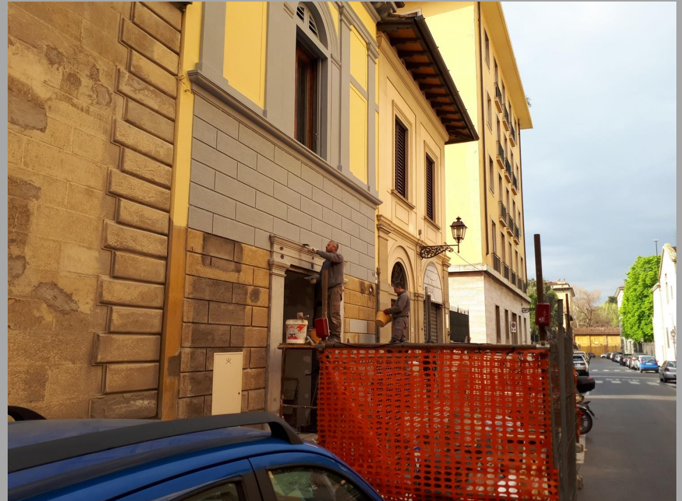
Pietra artificiale restaurata con stuccatura andante a cemento
