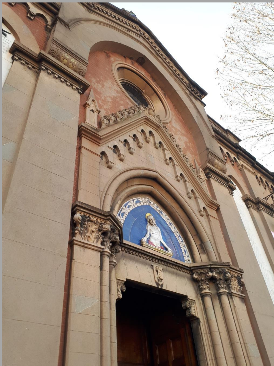
Facciata composta con elementi in pietra artificiale
