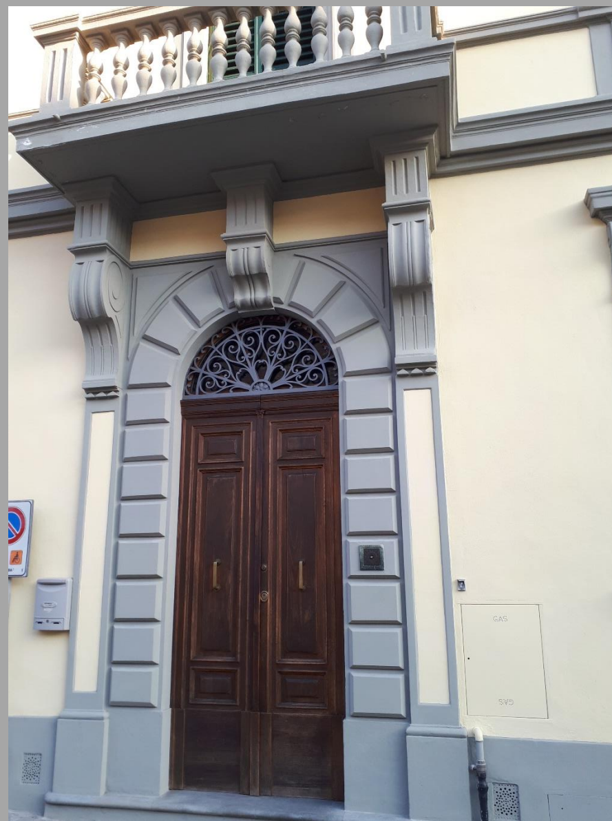
Facciata con elementi stuccati a cemento
