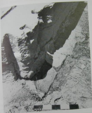
Figure 37 : Massif de la rive gauche du barrage de Ras Shamra : du logement des poutres et planches ; au pied du massif, marques d'érosion.
