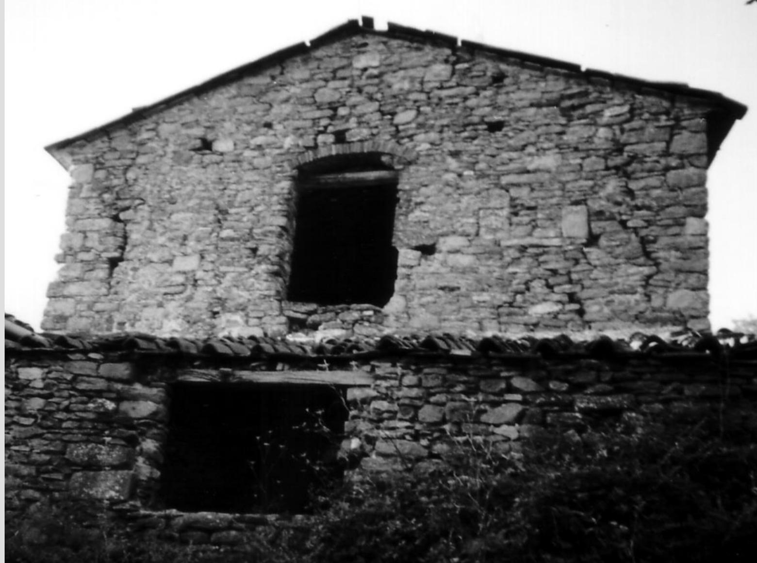
Grave stato fessurativo della muratura di facciata di questo edificio rurale dell'Appennino toscano dovuto principalmente al parziale crollo dell'orditura secondaria della copertura. Nell'apertura si intravede la catena di una delle capriate lignee che sorreggono ancora ciò che resta del coperto.
