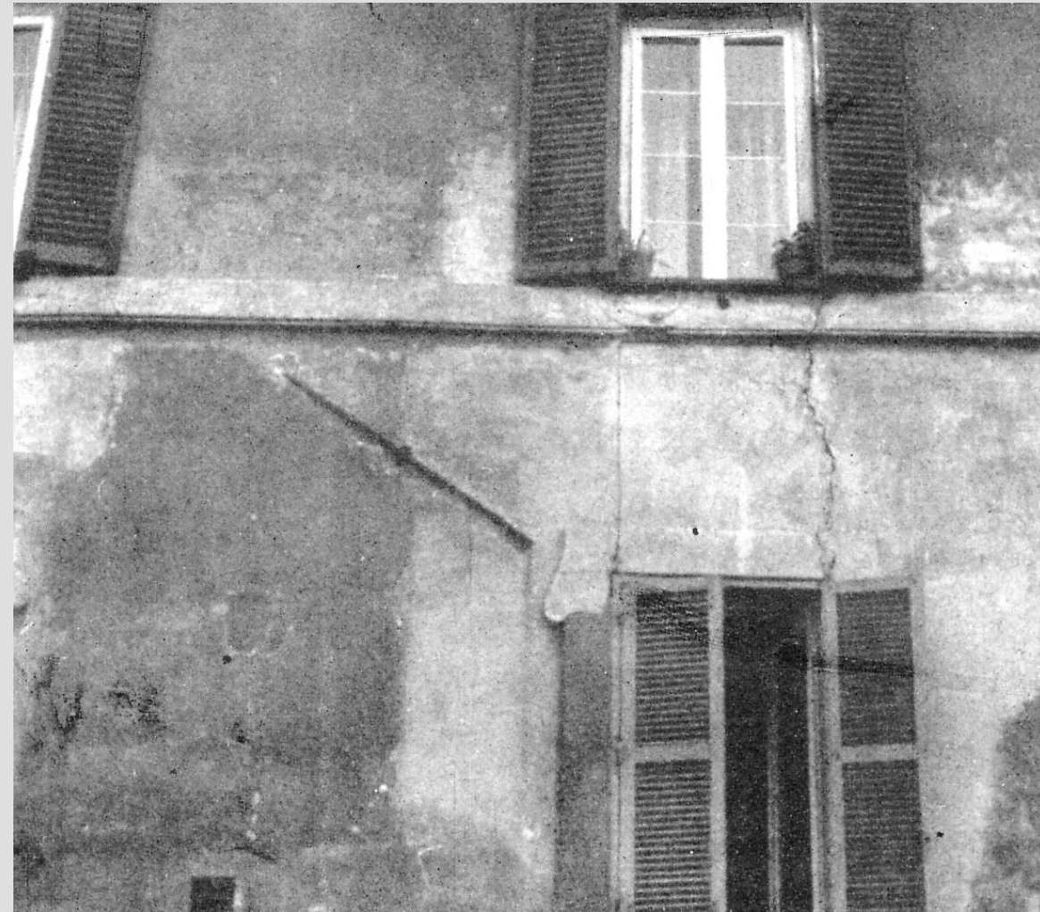
Consolidamento con tirante metallico. Il capochiave a paletto è posto inclinato per contrastare da un lato (destro) con il solaio e dall'altro (sinistro) con il muro interno trasversale.
