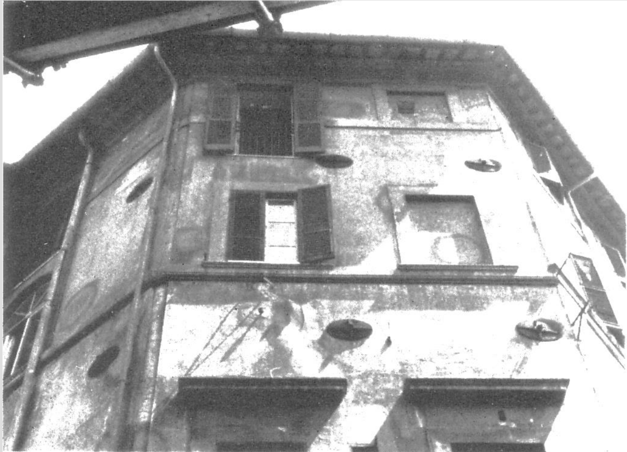
Esempio di tiranti metallici con capochiave a piastra ellittica.
