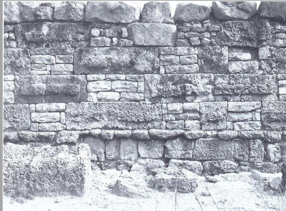
Velia, muro in struttura a scacchiera.
