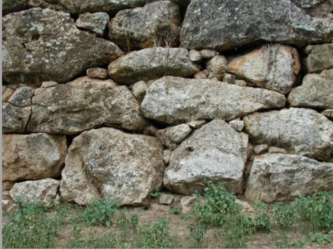
Opera poligonale calzata, o scalare
