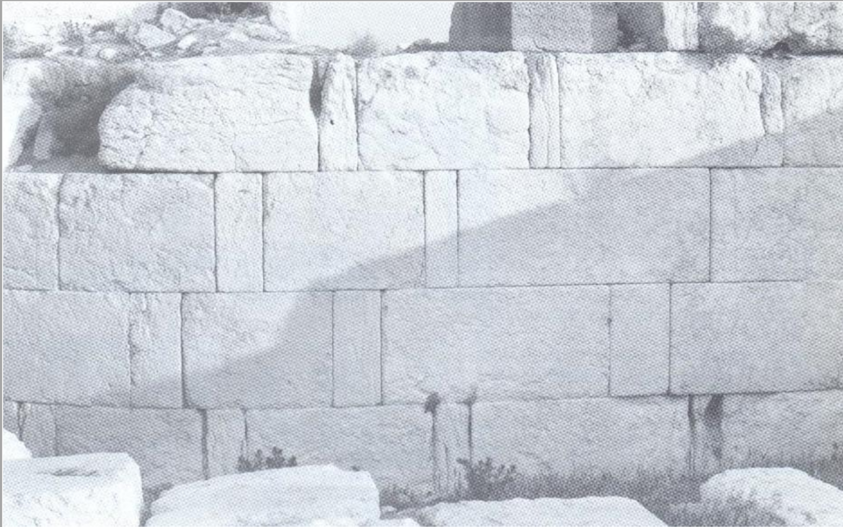
Muratura con regolare alternanza di ortostati e diatoni.
