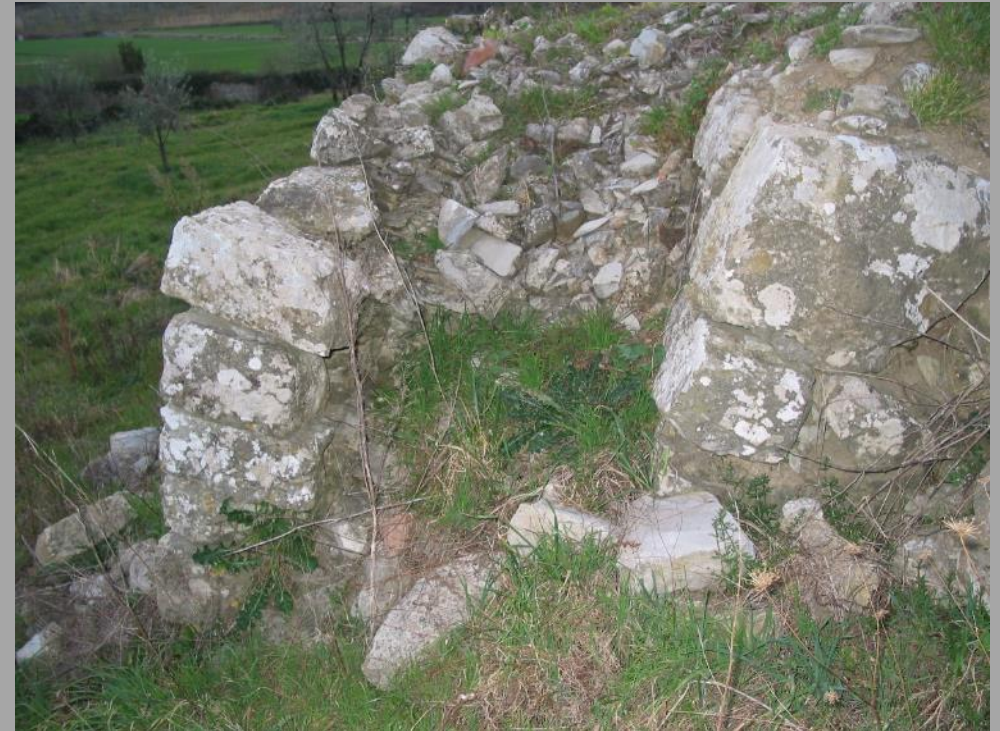
Muratura a secco costipata
