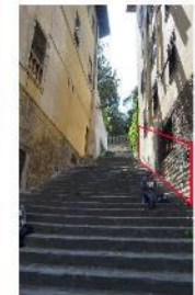
Avvicino di un cantiere lungo la rampa
