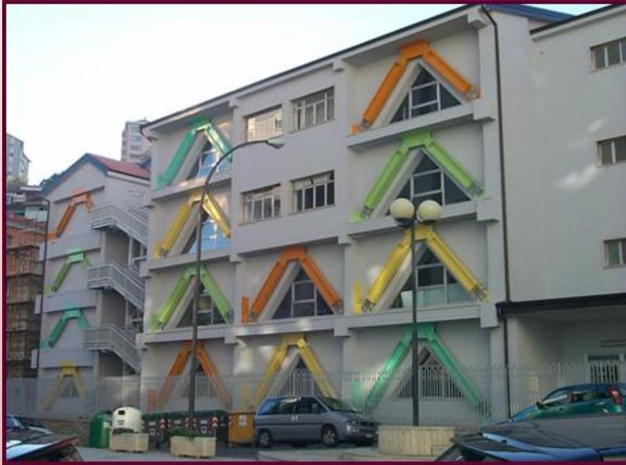
***Adeguamento sismico mediante coprighiunti dissipativi metallici della scuola "D. Viola" a Potenza***
