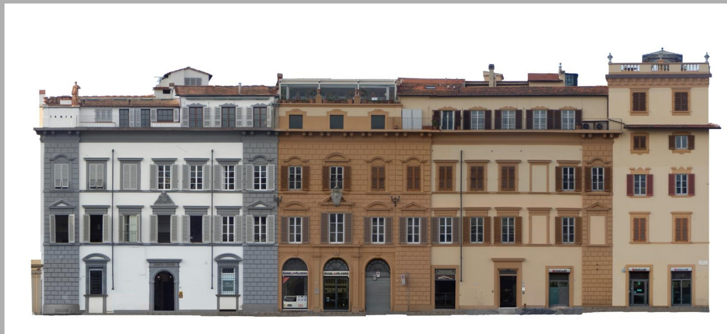
Edifici in Lungarno Guicciardini
