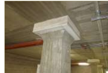
Immagini relative alle tubazioni dell'impianto idrico all'interfaccia, e di due colonne prima e dopo la realizzazione di un carter di protezione degli isolatori
