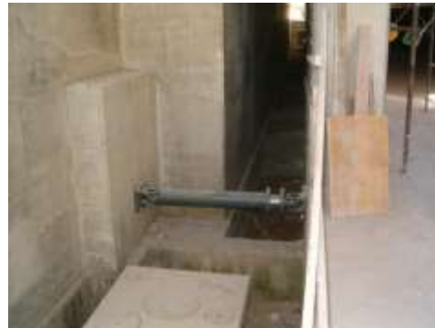
Vista di un dispositivo durante la fase di completamento della sovrastruttura
