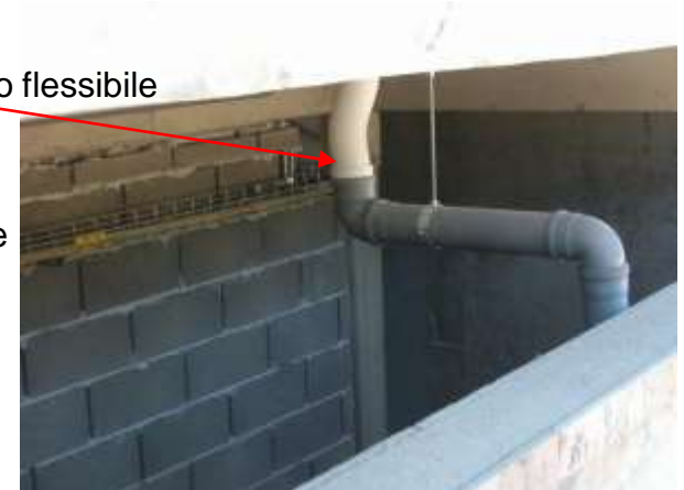
Raccordo flessibile impianto idraulico
