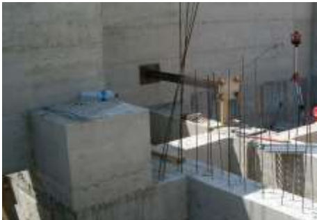
Vista di una delle dime d'acciaio posizionate, in qualità di distanziatori sostitutivi dei dispositivi fluido-viscosi, prima del getto dell'impalcato mobile
