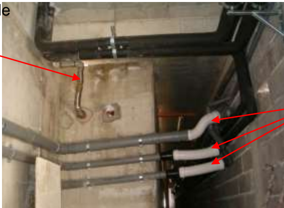
Raccordo flessibile impianto idraulico
