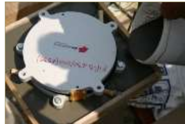
Posa in opera degli isolatori sul baggiolo
