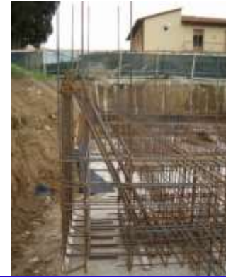
Vista delle armature dei contrafforti di reazione dei dispositivi siliceosi
