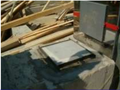
Posizionamento degli isolatori in acciaio-PTFE sui rispettivi baggioli
