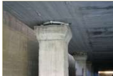
Immagini relative alle tubazioni dell'impianto idrico all'interfaccia, e di due colonne prima e dopo la realizzazione di un carter di protezione degli isolatori
