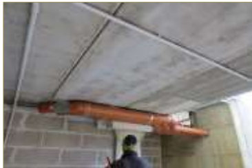
Immagini relative alle tubazioni dell'impianto idrico all'interfaccia, e di due colonne prima e dopo la realizzazione di un carter di protezione degli isolatori
