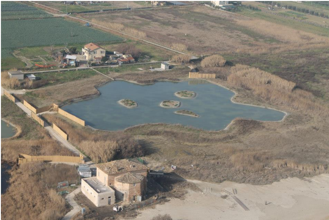
Foto 14: Realizzazione dello stagno d'acqua dolce
