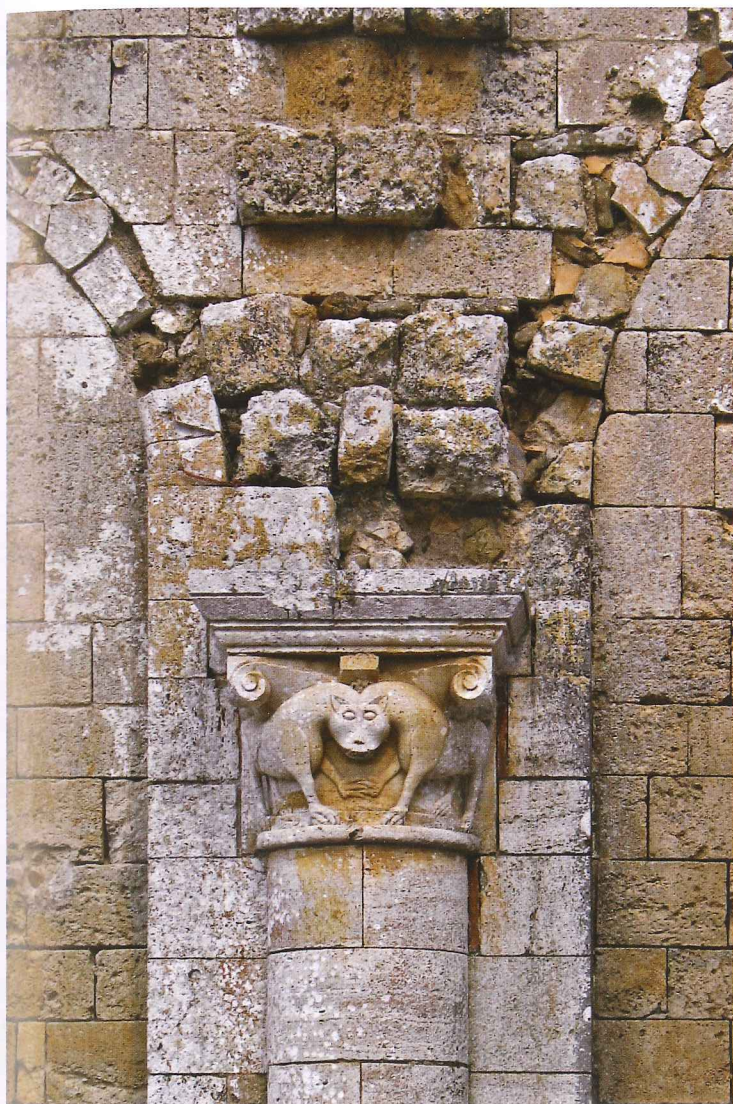
25. S. Antimo, facciata, semicapitello con due leoni aventi testa in comune.
