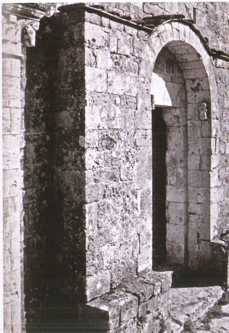
32. Badia Ardenghesca, facciata, portale in iscorcio.
