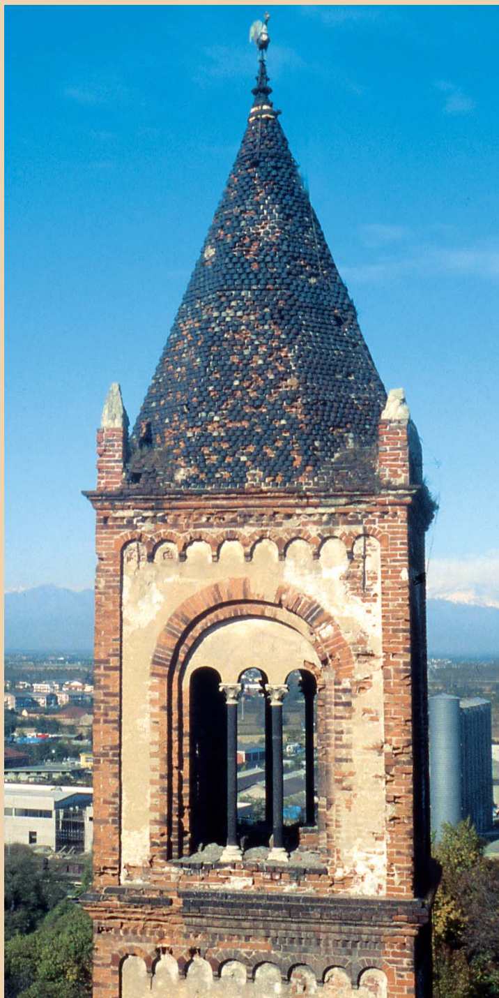
Cuspide della torre ottagonale del tiburio di Sant'Andrea, secondo quarto del sec. XIII, Vercelli (particolare con la copertura invetriata)
