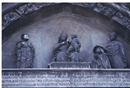
Fig. 6: Esempi di fenomeni di erosione e annerimento (*Foto di proprietà della dott.ssa M. Laurenzi Tabasso).
