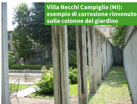
Villa Necchi Campiglio (MI): evidenza di incrostazioni nere sui muri del Bene FAI
