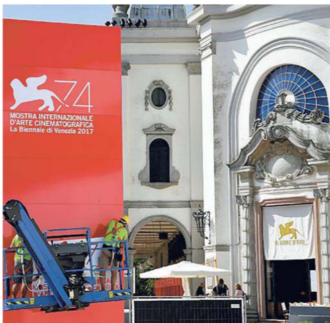
LAVORI IN CORSO Ultimi preparativi prima dell'inizio
