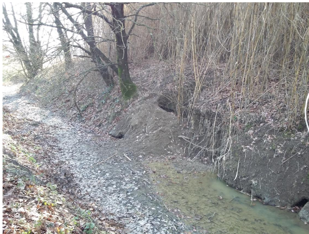
Tunnel scavati dalle nutrie che rischiano di far crollare l'argine
