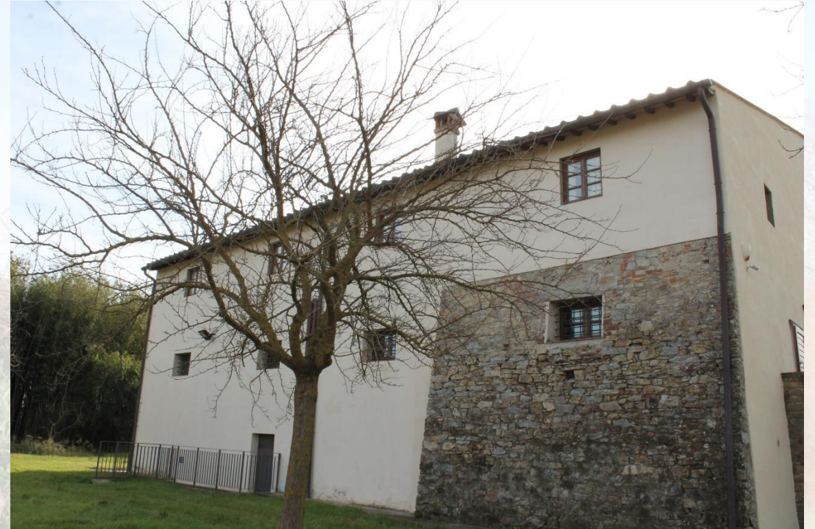
Casa di Zela vista da dietro. Muro in mattoni originario della torre.
