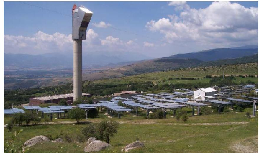
Figura 4. Solare termoelettrico a concentrazione.
