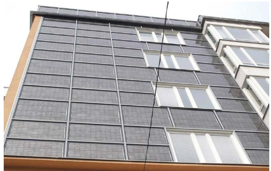
*Figura 60. Tecnologie attive (pannelli fotovoltaici) integrati oltre che sui tetti, anche sulle facciate degli edifici*
