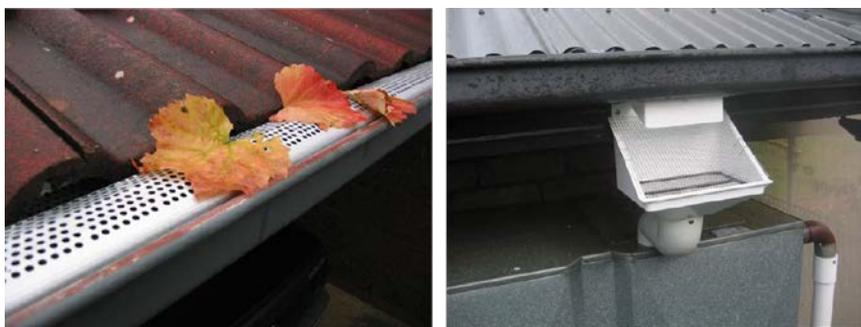
Figura 13. Esempi di primo filtraggio delle acque meteoriche, direttamente applicabili sulle gronde degli edifici.
