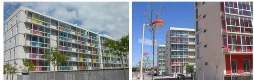
Figura 51. Facciate esposte a sud con sistemi di vetrate per la captazione del calore durante le stagioni fredde. In estate la ventilazione interna favorisce il naturale raffrescamento nelle ore notturne.
