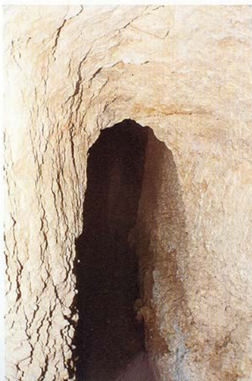
Foto 26 - Tratto di qanat in calcarenite particolarmente tenace.
