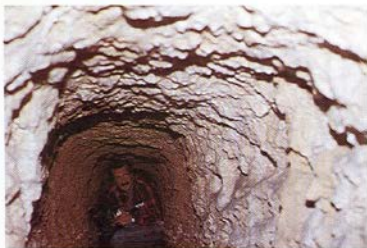
Fig. 24 - Uno stretto passaggio del qanat di via Pindemonte.
