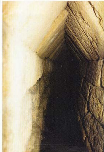
Foto 27/b - Tretto di qanat all'incrocio di corso Calatafimi con la Circonvallazione alla profondità di circa 10 m. La copertura è realizzata con lastroni calcarenitici posti a «bocca di fornace».
