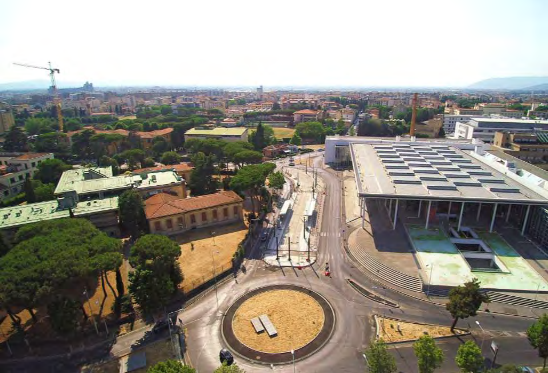
Il terminal della T3 in completamento presso il Policlinico di Careggi (foto L. Pagnini, 07/2017)
