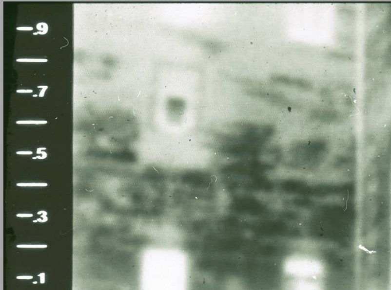
Il termogramma evidenzia discontinuità murarie
