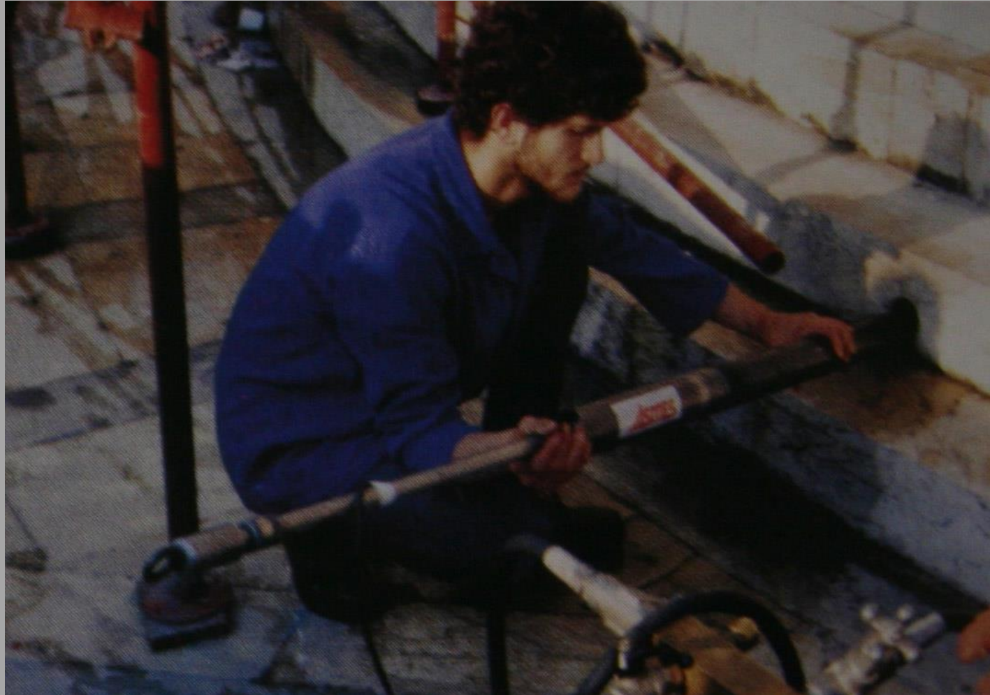
Torre di Pisa, prova dilatometrica in foro per lo studio della deformabilità delle fondazioni (Conc. ISMES, Bergamo)
