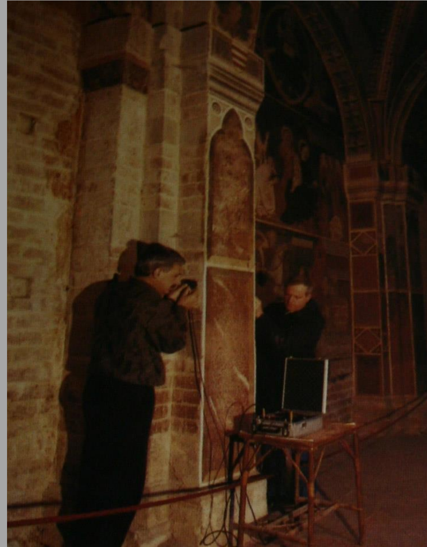
Prove soniche per trasparenza su un pilastro (ISMES)
