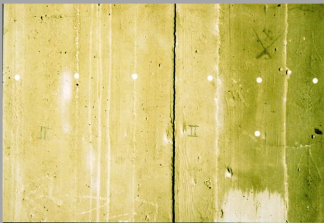
Parete in c.a., immagine al visibile
