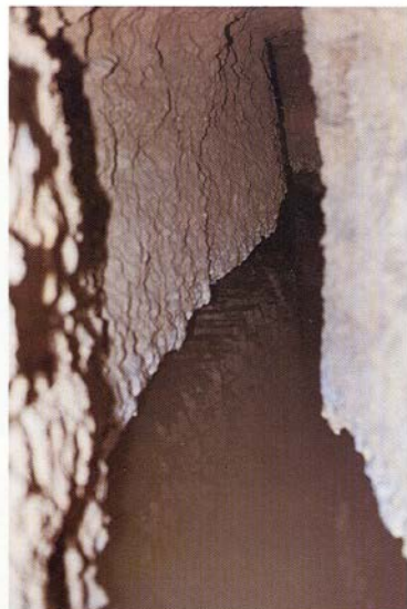
Foto 27/a - Tratto in curva per evitare un banco di roccia dura.
