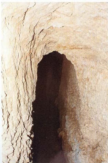
Foto 26 - Tratto di qanat in calcarenite particolarmente tenace.
