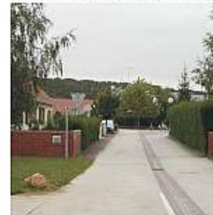
Dans les rues résidentielles, lorsque le quartier est peu perméable aux déplacements du reste de l'agglomération, la zone de rencontre permet d'aménager des espaces publics plus conviviaux.
