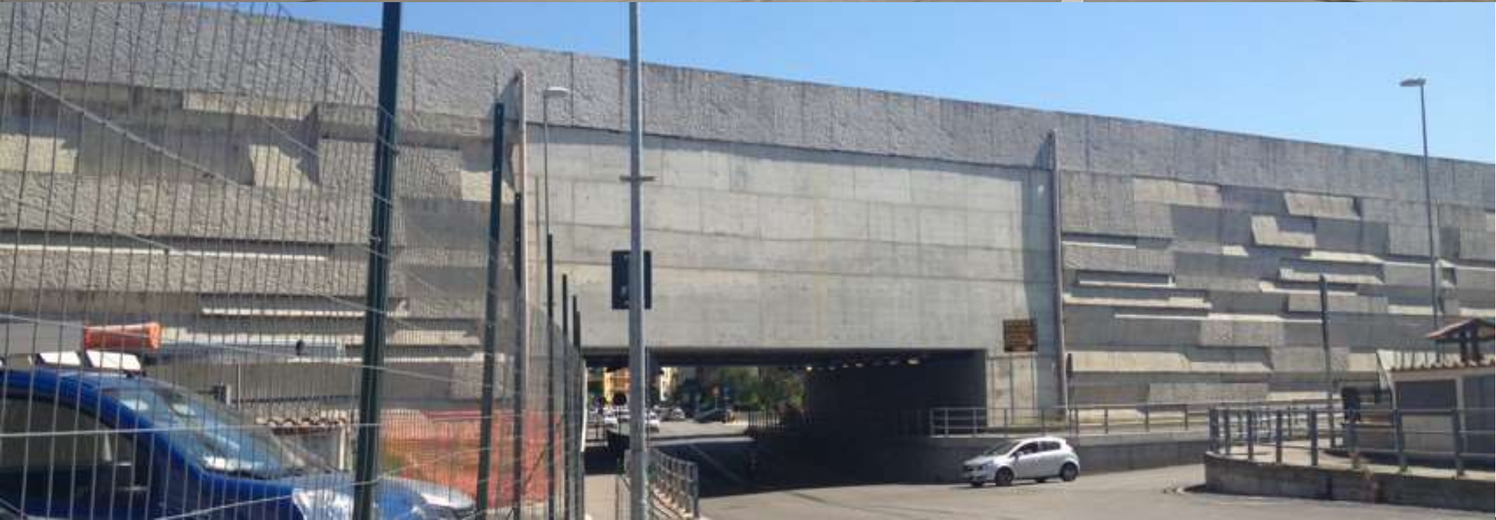
A1, Galleria artificiale di Casellina (Scandicci). Sistemazione paesaggistica (L. Vallerini) – avanzamento lavori
