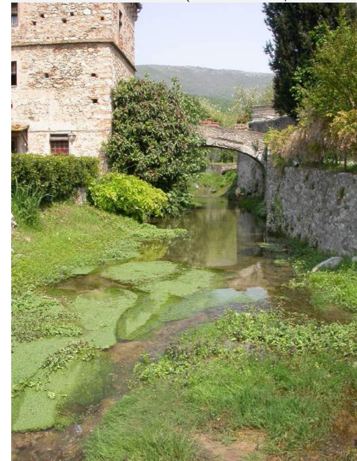
Pianura di Travalle (PO): Torrente Marinella con ecosistemi torrentizi e vegetazione palustre e ripariale. (Foto: L. Lombardi, archivio NEMO)
