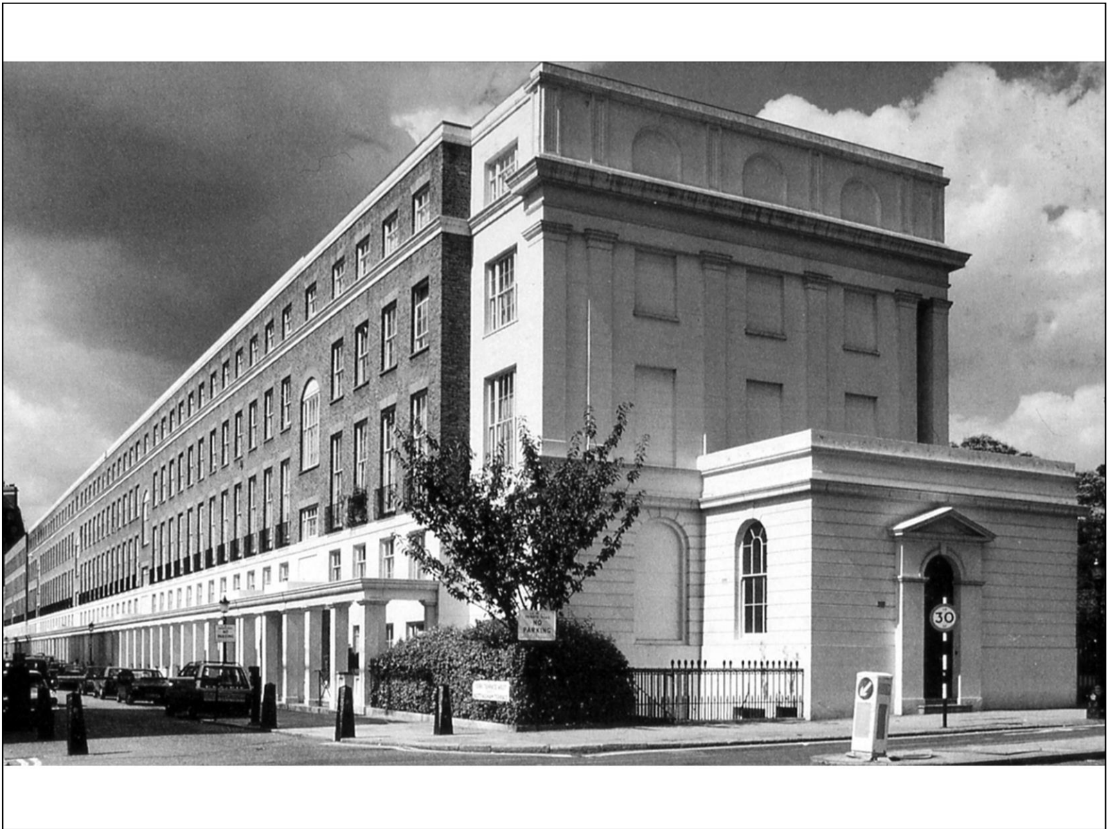
J. Nash, York Terrace West, Londra: lato verso la strada
