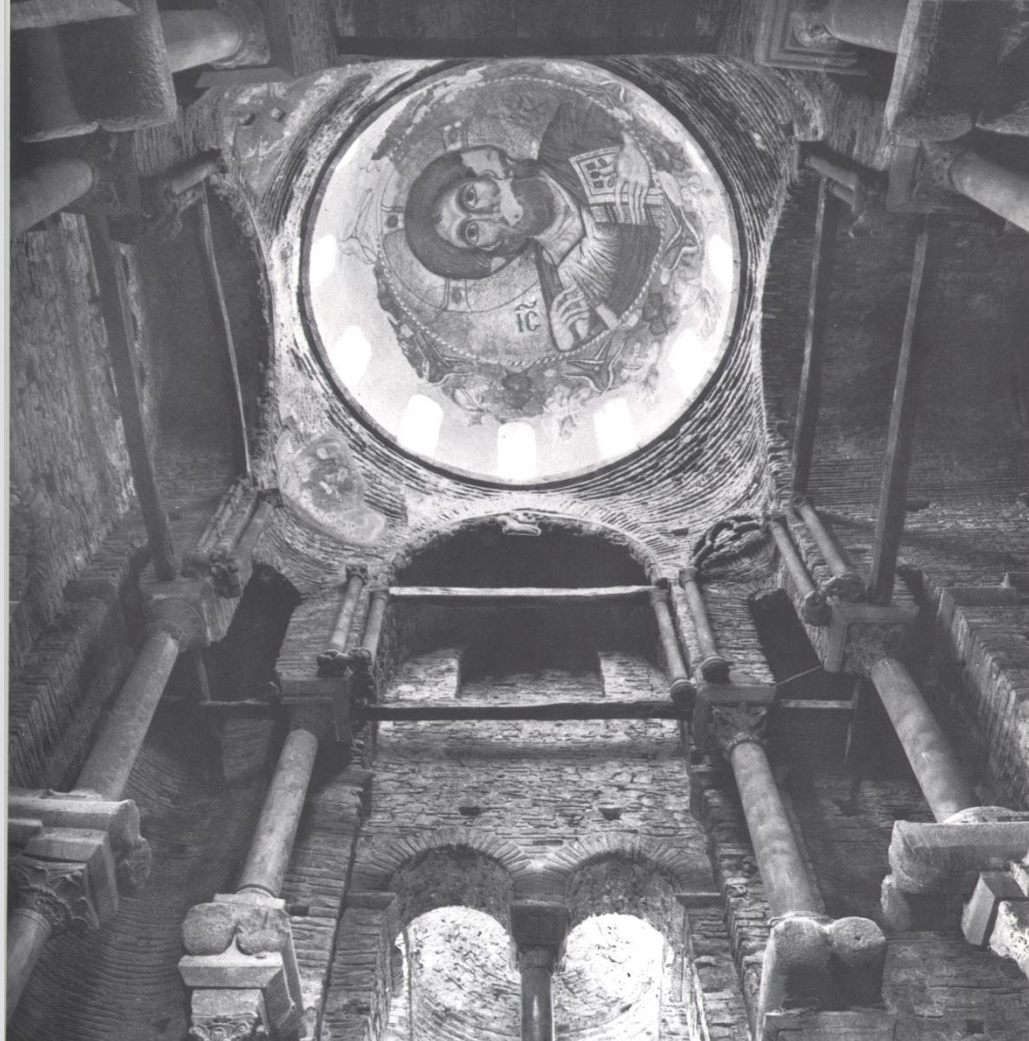
Figg. 28, 29 - Cupola e sistema dei pennacchi angolari sostenuti da colonne e trattenute da tiranti lignei. Spaccato assometrico della tribuna. Arta, chiesa della Parigoritissa, XIII secolo.
