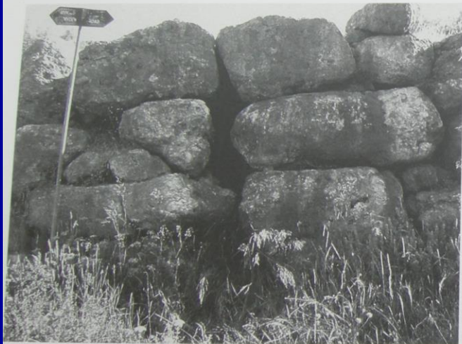
Fig. 17. Culvert at Drakonera.
